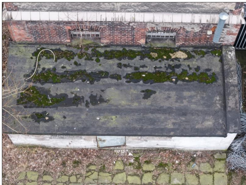
Fot. 12. Dobudówka przy elewacji północnej. Widoczny rozwój mchów i roślinności zielnej na powierzchni dachu.
